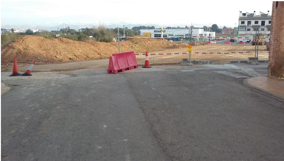
Entrada y salida aparcamiento las Nieves desde calle Virgen del Carmen
