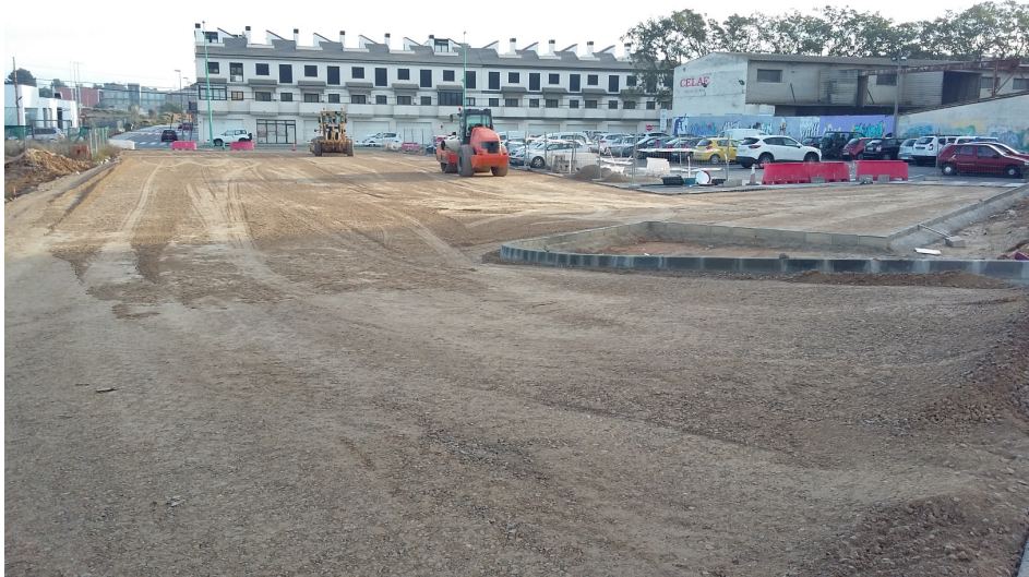
Aparcamiento Las Nieves, actualmente en obras por ampliación
