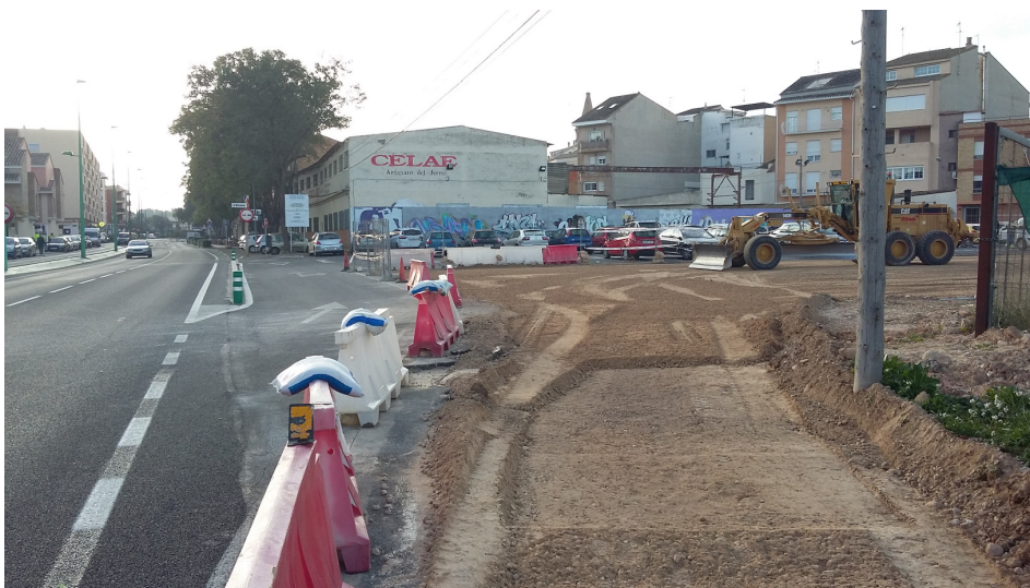
Entrada aparcamiento las Nieves desde CV-375
